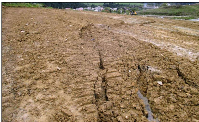
Obr. 3 Trhliny v trase privádzača nad výkopom pre preložku potoka.
